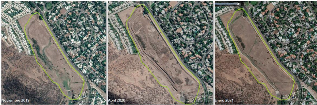
Ilustración 2-7 Evolución Obras de Canalización Quebrada El Carrizo
